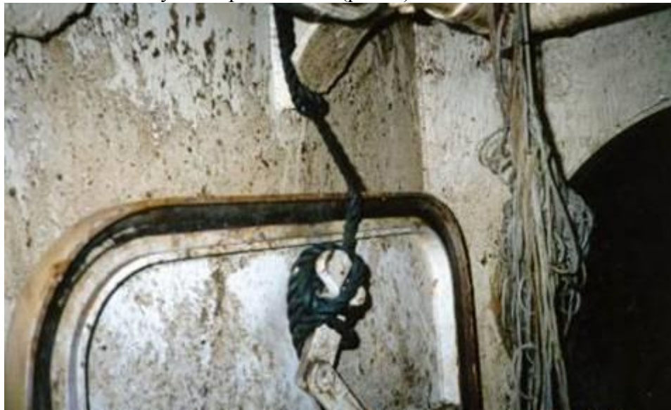
Рис. 4. Протипожежні двері відчинені
