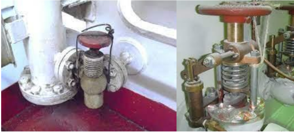
Рис. 3. Клапани швидкого закриття тримаються відкритим за допомогою каната
