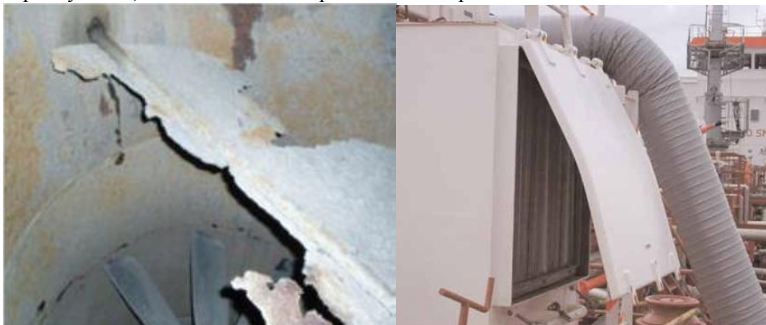
Рис. 2. Пожежні заслінки які не можуть закритися
