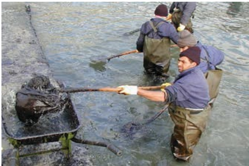
Рис. 7 Усунення важкої паливної нафти вручну, яка опустилась на дно
